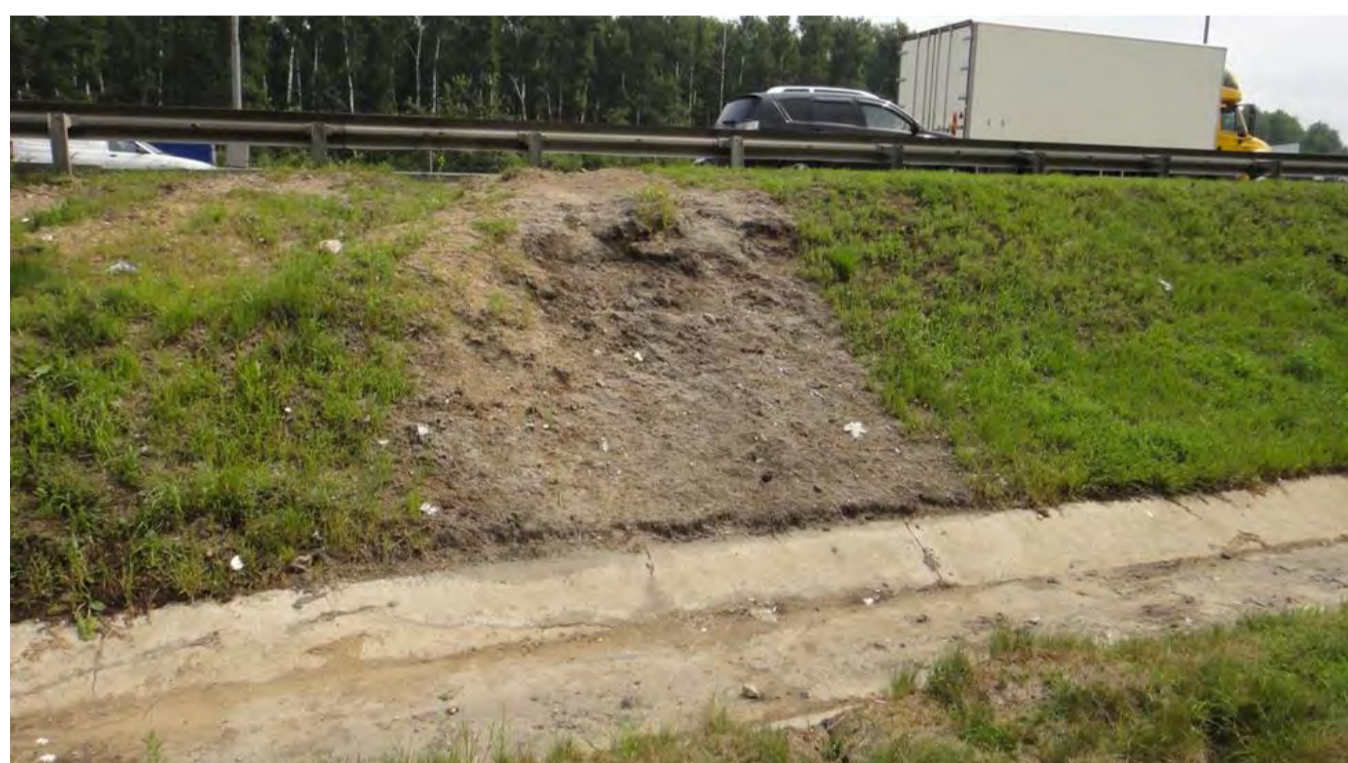
Рис.1,2,3. В результате аварии бензовоза произошло загрязнение объектов окружающей среды как в месте аварии, так и на противоположной стороне автотрассы, в результате миграции НП через систему ливневого сброса в озеро на территории ООПТ.
