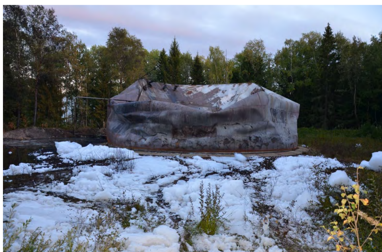
Рис.4,5. Загрязнение объектов окружающей среды НП в результате пожара в нефтехранилищах.
